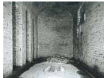
Eiskeller der ehemaligen Brauerei Beuing
