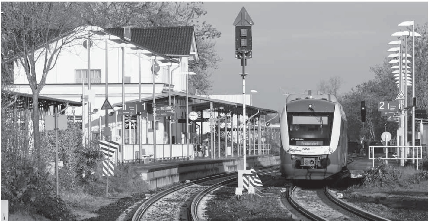
Nach der Streckenrenovierung ist hier ein Zug der RheinRuhrBahn im Bahnhof Kempfen zu sehen
