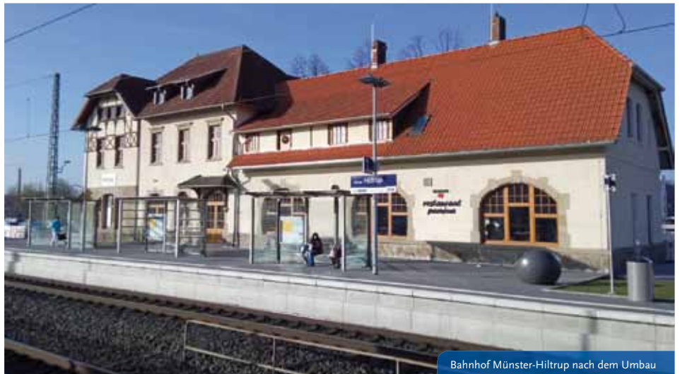
Bahnhof Münster-Hiltrup nach dem Umbau
